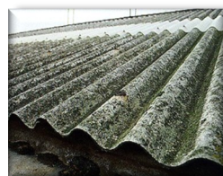
Toitures en plaques ondulées
